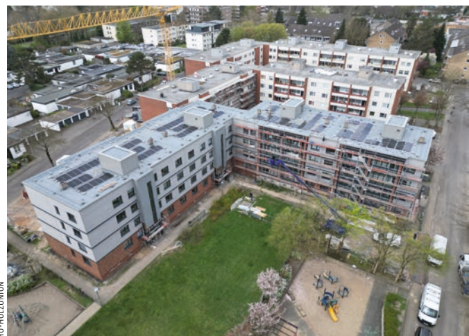
▲ Quartierssanierung mit Herz, Holz und Sachverstand: Die Holzunion bringt seit 2024 drei 4-geschossige und einen 6-geschossigen Riegel mit über 100 Wohneinheiten auf den aktuellen Stand
