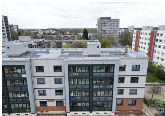
▼ Umsichtig geplant: Die serielle Sanierung der Loggien mit vorgefertigten und vorgestellten Elementen spart Zeit und Eingriffe in die Bestandsfassade
