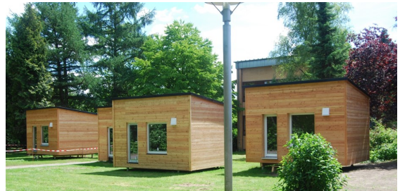
Die Versuchsgebäude auf dem Gelände des Thünen-Institutes in Hamburg
