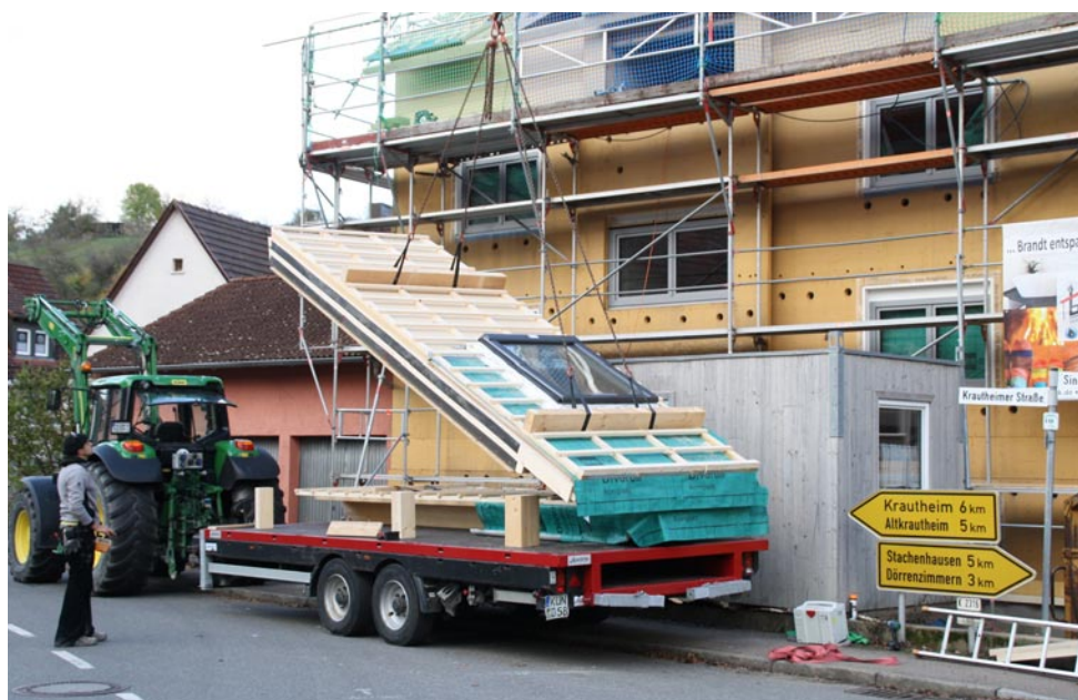
Elementierter Dachbau: Die einzudeckenden Dachflächen wurden elementweise vorgefertigt und inklusive eingebauten Fenstern auf die Baustelle geliefert.
