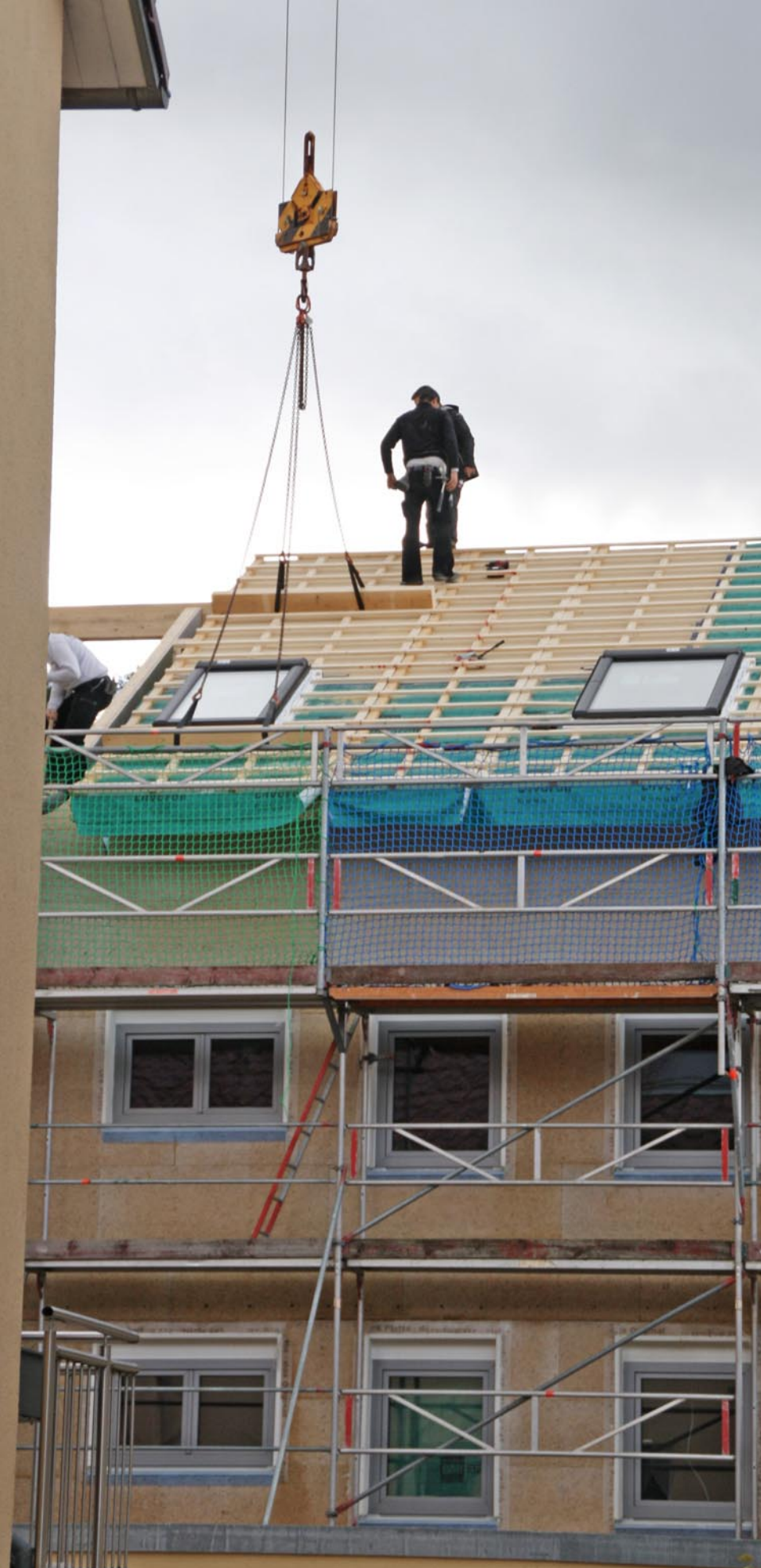
Zum Eindecken und Verputzen vorbereitet: Das Eberstaler Mehrfamilienhaus entwickelte sich im Zuge der Sanierung Schritt für Schritt zu einer Augenweide.
