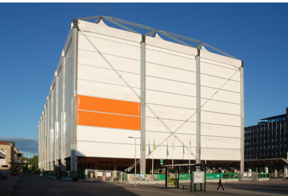
Abb. 9a und b: Selbst stehendes Schutzdach auf Stützen mit Kranbahn.
