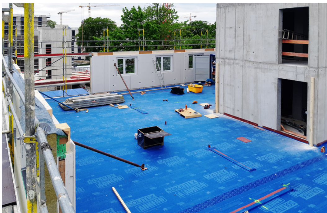
Abb. 13: Montierte Witterungsschutzbahn. Öffnungen. Stahlschwerer und Treppenhäuser sind bereits angeschlossen.
