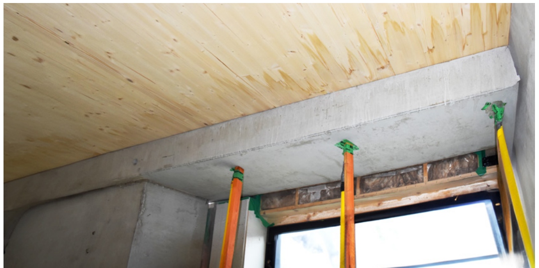
Abb. 15: Anschluss von Trocknungsschläuchen am Deckenaufleger an werksseitig vorgerichtete Rohre.
