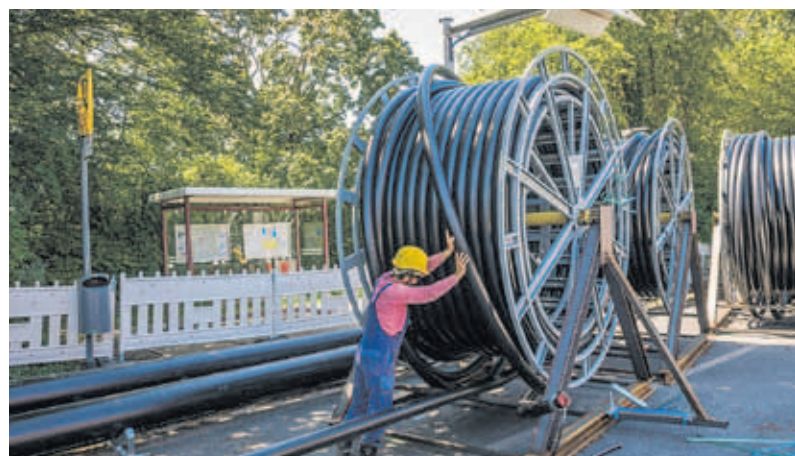
Auf 3,20 Meter hohen Trommeln wurden die Schutzrohre angeliefert. Fotos (4): Dirk Balzer/Stadtnetze Münster
