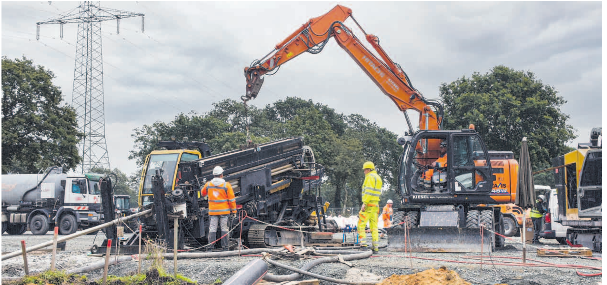
Als Alleskönner bewährt sich ein Hitachi ZX145W beim Bau einer Höchstspannungsleitung in Ostfriesland. Die Max Streicher GmbH setzt den Mobilbagger mit OilQuick-Schnellwechsler und-Tiltrotator-Sandwich ein. Im Minutentakt kann der ZX145W so alle Anbaugeräte wechseln. Foto: Kiesel / Bodo Wistinghausen
