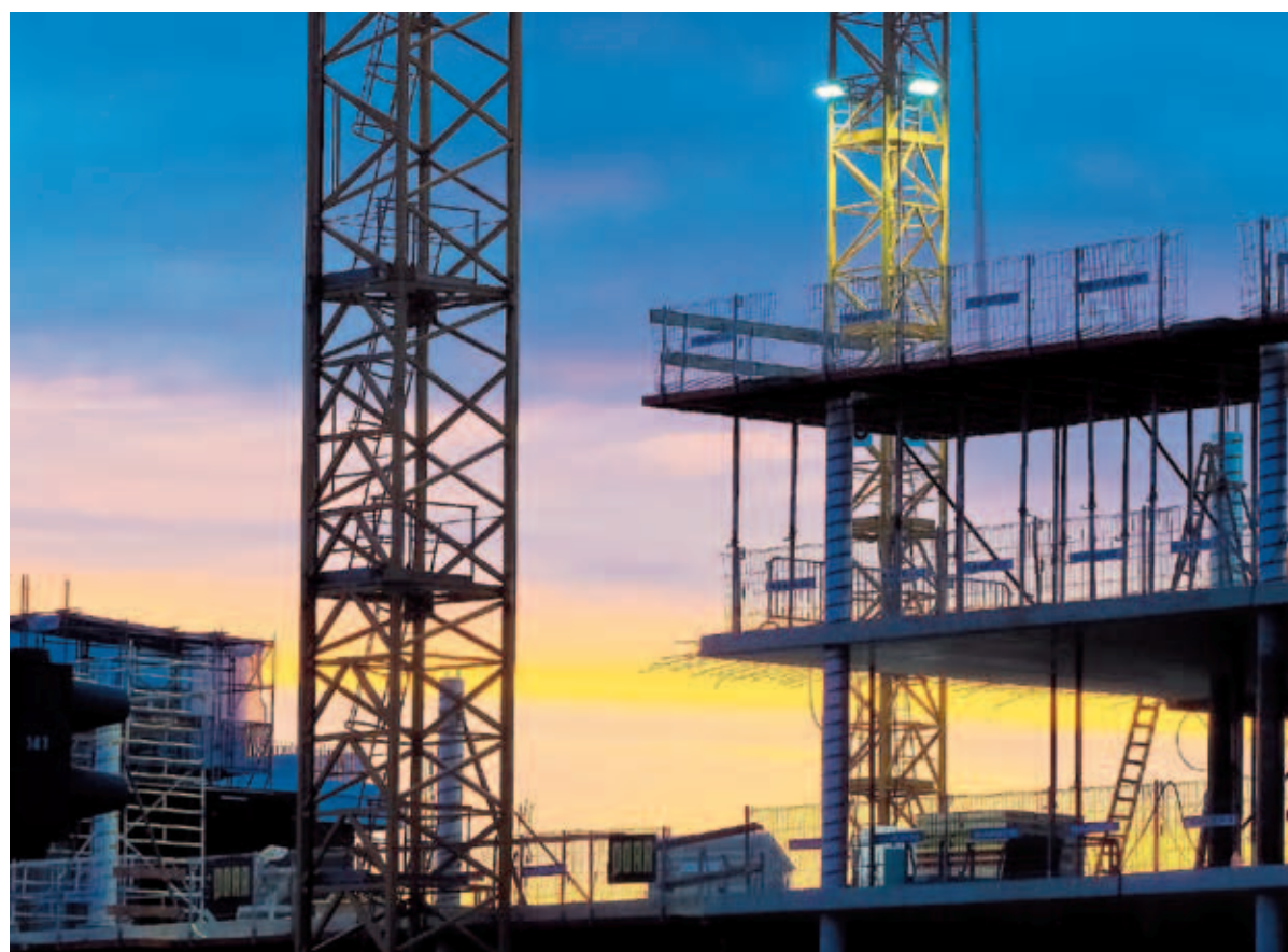
Die Initiative „Deutschland baut!“ sieht die Wertschöpfungskette Bau als sehr innovativ an. Nahezu alle Gewerke können diese Kraft, sich oder ihre Produkte ständig zu erneuern, auch vorweisen. Jetzt muss das besser vermarktet werden.
