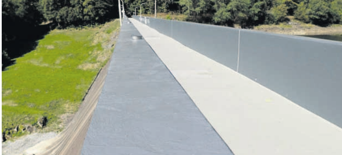
Spezialbeschichtung auf der Mauerkrone.
