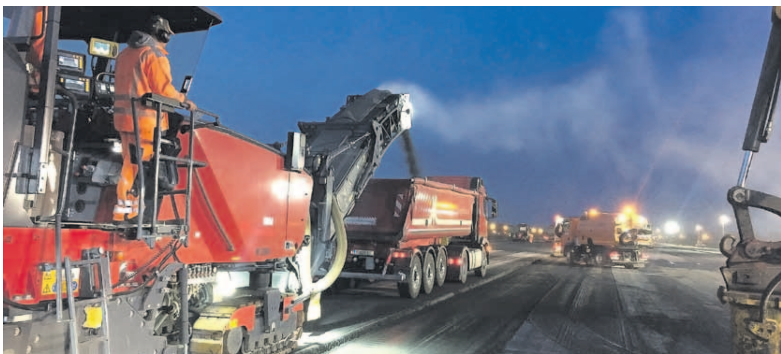
Das exakt vorausgeplante Fräsen der Altdecke ist der Kern des SmoothRide-Prozesses von Topcon, um am Ende eine absolut plane neue Oberfläche zu bekommen.
