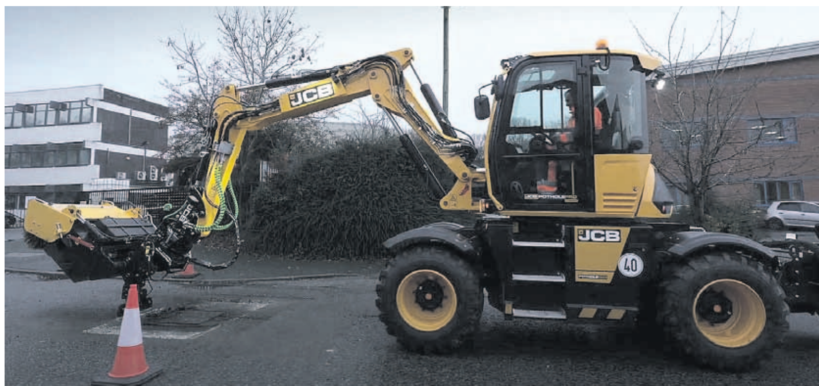
Der Pothole Pro – frei übersetzt Schlagloch-Profi – fräst, schneidet und säubert ein Schlagloch. Im Anschluss muss das Loch nur noch befüllt und verdichtet werden.
