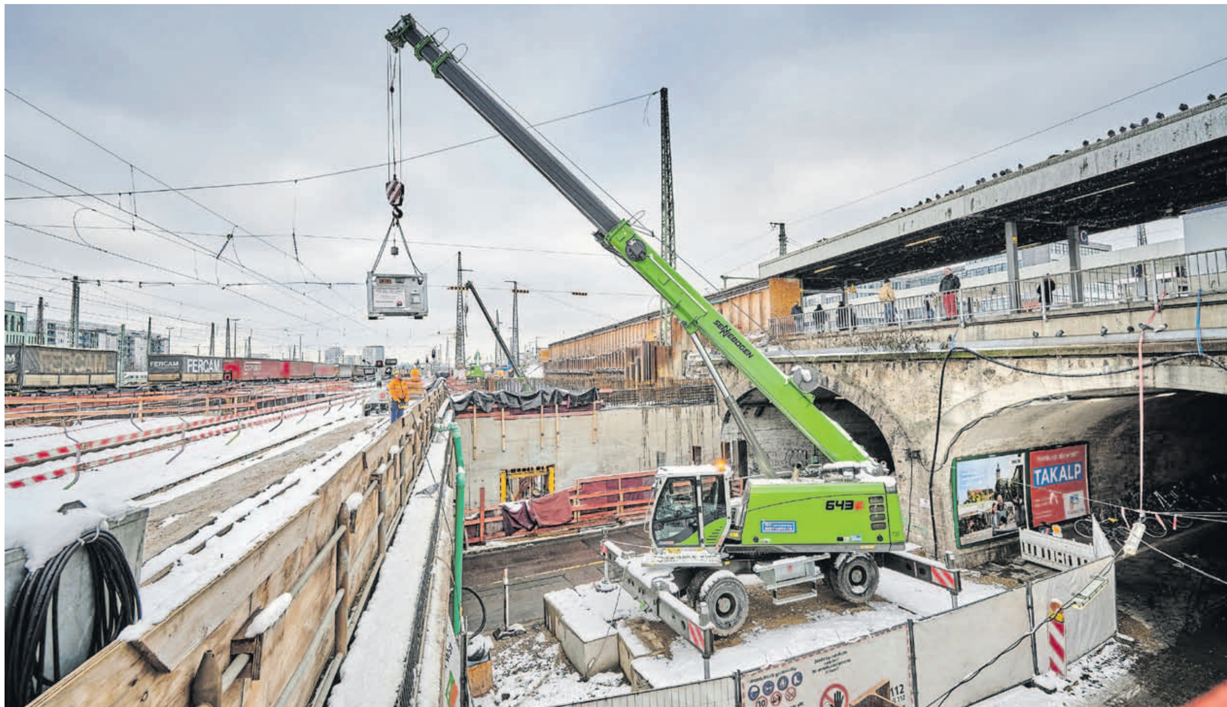
Auf dieser verschneiten Bahnbaustelle hat der SENNEBOGEN 643 E wenig Platz zum Arbeiten. Per Fernbedienung steuert der Fahrer von außerhalb die Hubarbeiten.
