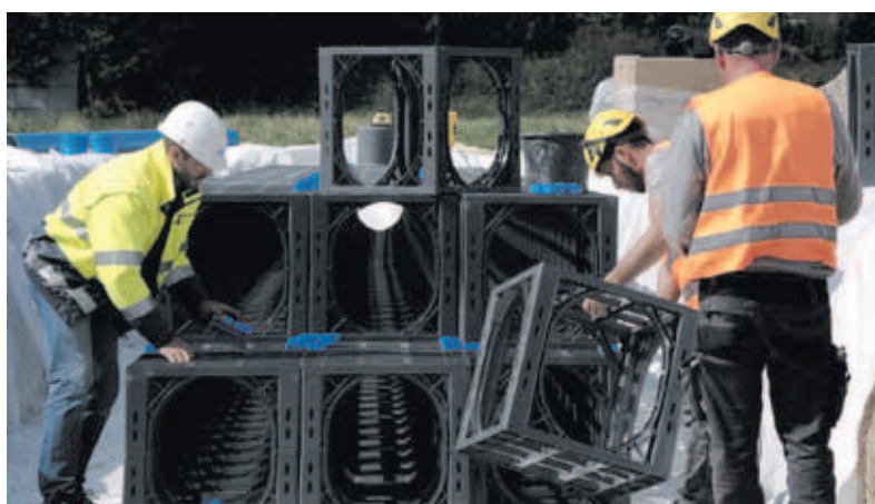
An der Einbaustelle sind die Elemente leicht zu handhaben.
