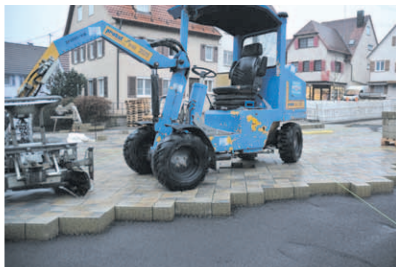
Die Verlegung des Pflasters erfolgte zu großen Teilen maschinell. Foto: SF-Kooperation GmbH Beton-Konzepte
