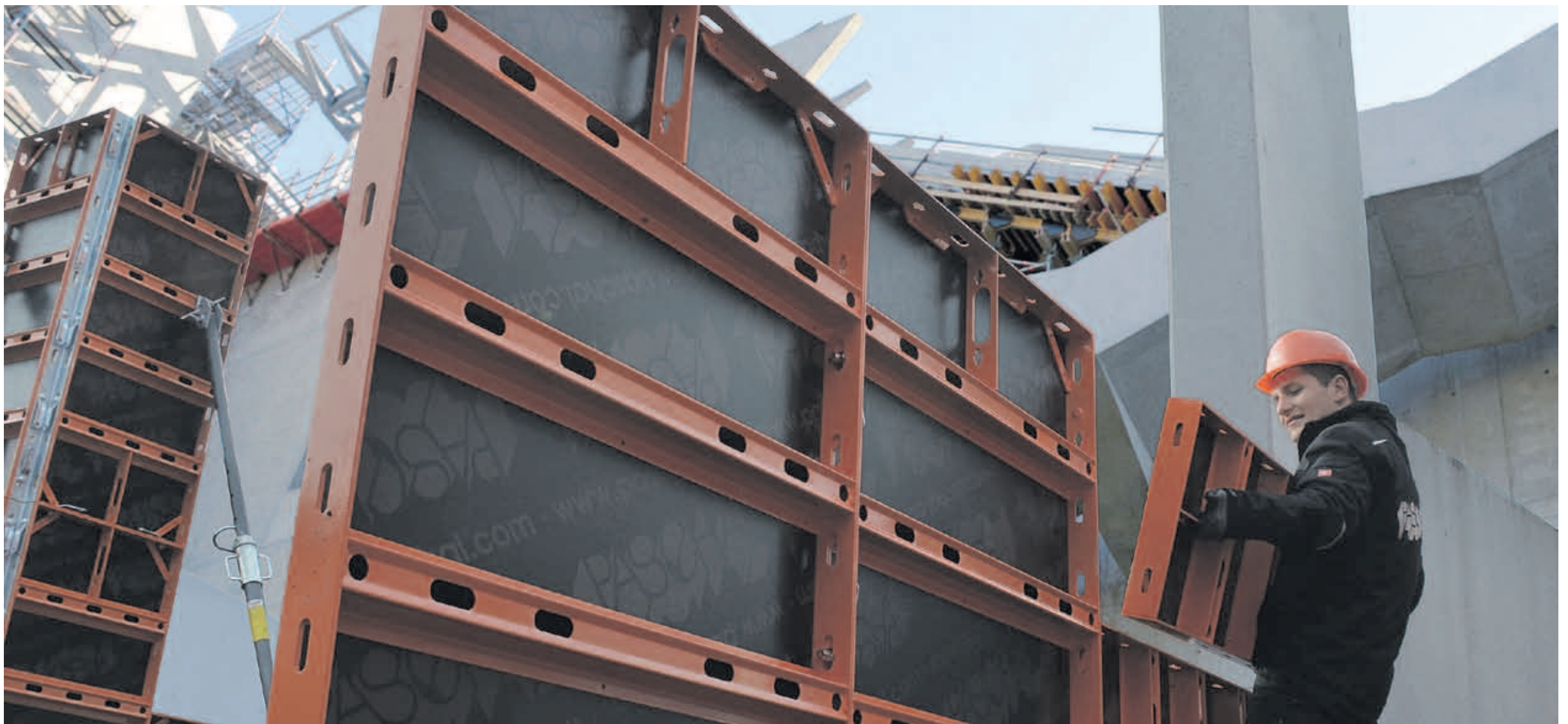
Die NeoR-Leichtschalung von PASCHAL kann als Hand- und Großflächenschalung eingesetzt werden. Ihre hohe Flexibilität und die ausgewogene Elementsortierung machen die NeoR damit zur idealen Schalung – zum Beispiel für ein Bauprojekt in Hannover-Kleefeld (siehe Seite 37).
