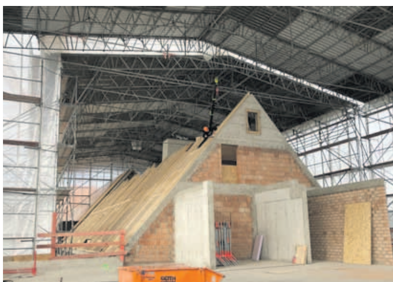
Das Wetterdach plettac 75 umfasst eine Fläche von 1.660 Quadratmetern.
