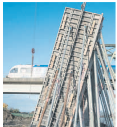
Die neue Radbrücke passt sich an die benachbarten Bahnbrücke an. Foto: NOE Schaltechnik
