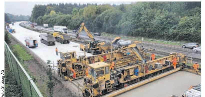
Während der Bauarbeiten soll der Verkehr auf der A1 zwischen Löhne und Bramsche weiterlaufen.
