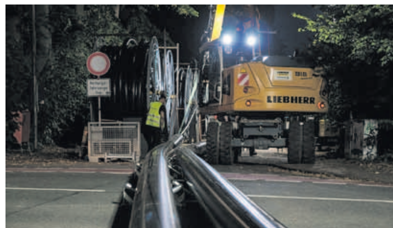
Nur bei der kompletten Auslegung der Schutzrohre waren Straßensperrungen notwendig.
