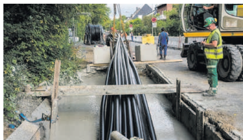
Die einzelnen Schutzrohre werden als Leitungsbündel in das Bohrloch eingezo- gen.
