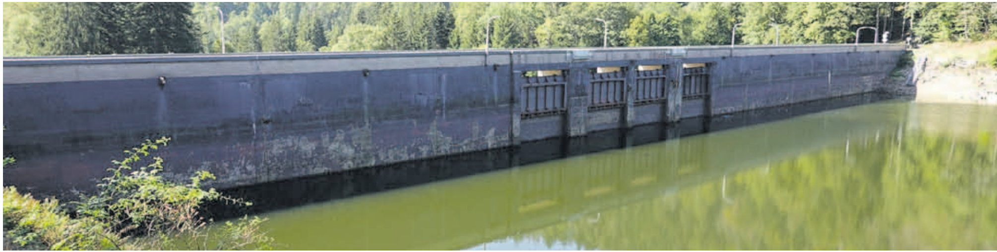
Die Staumauer ist 1941 gebaut und in den 1980er Jahren neu instandgesetzt worden. Deshalb mussten zwei verschiedene Altbetonklassen beachtet werden.
