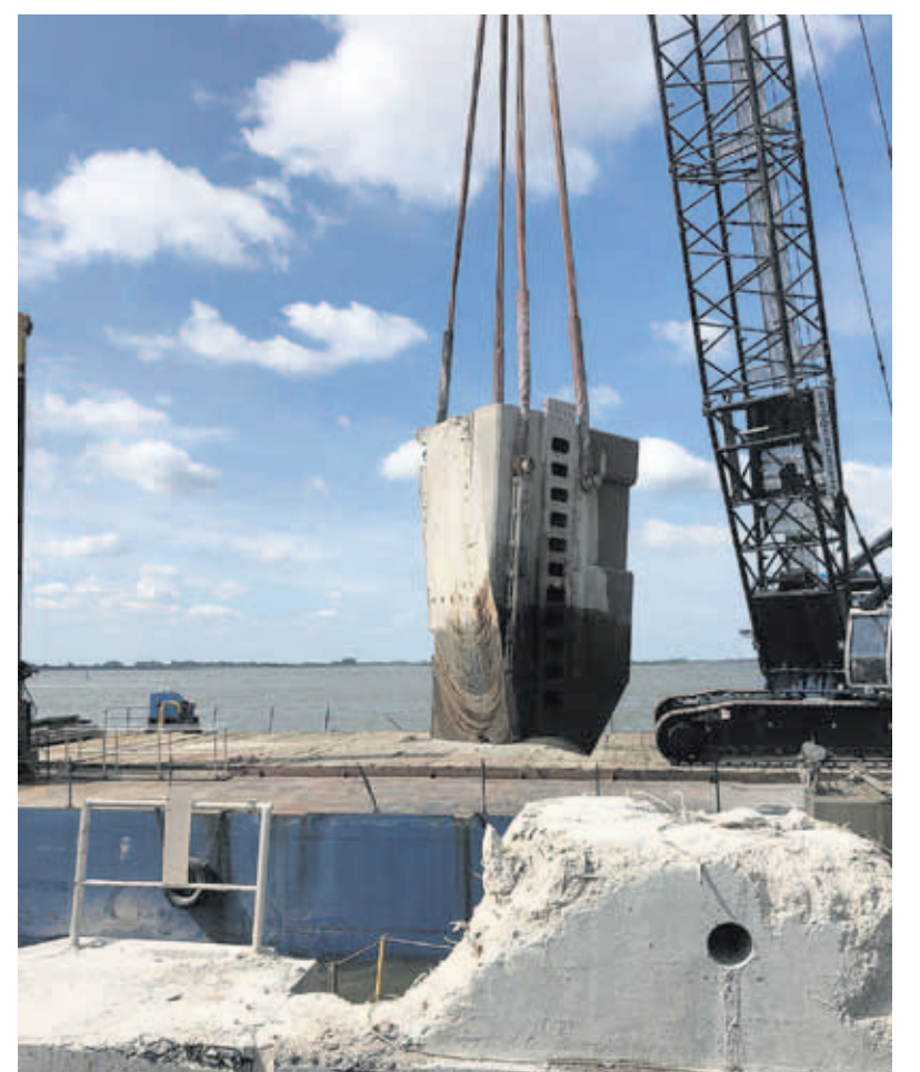
Die abgesägten Betonbruchteile wogen mitunter Dutzende Tonnen und wurden auf einen an der Kaje positionierten Ponton zum Abtransport gehoben.
