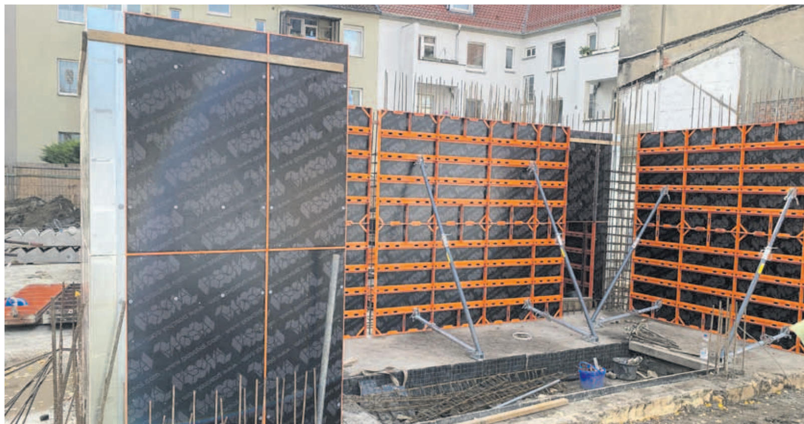
Für die Schalungsarbeiten im Treppenhaus mit Aufzugsschacht fiel die Wahl auf die neue NeoR Leichtschalung – anstelle der ursprünglich geplanten Holzschalung.
