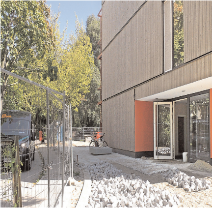
Ein Bauzaun sorgt für die nötige Sicherheit. Bild: ©Bärbel Reichenbach
