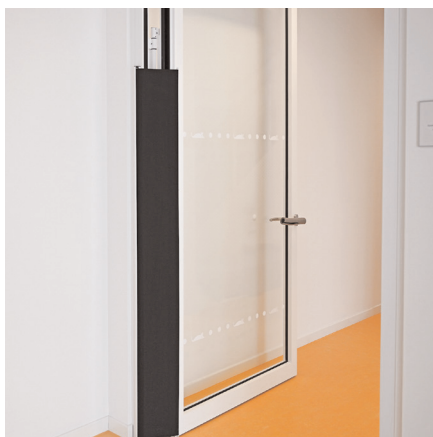
Die Türen sind mit einem Fingerklemmschutz versehen.
