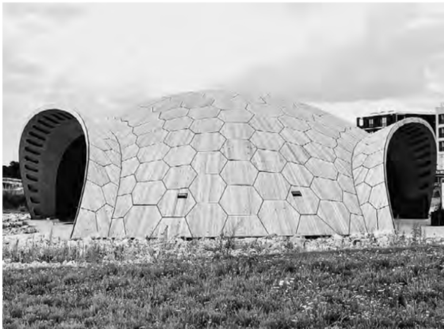
Mobiler Holzbau: Der sieben Meter hohe Holzpavillon war Publikumsmagnet auf der Bundesgartenschau 2023 in Mannheim. Das Bauwerk besteht aus insgesamt 411 demontierbaren Einzelteilen und wurde vom DHV-Mitgliedsunternehmen müllerblastein aus Lärchenholz gefertigt.
